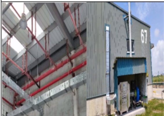
吸风罩、照明设施
