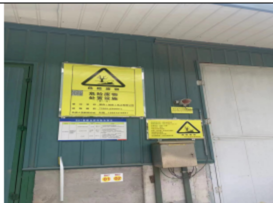
危废贮存设施标识牌
