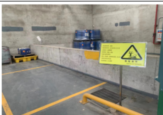
危废仓库内部隔间
