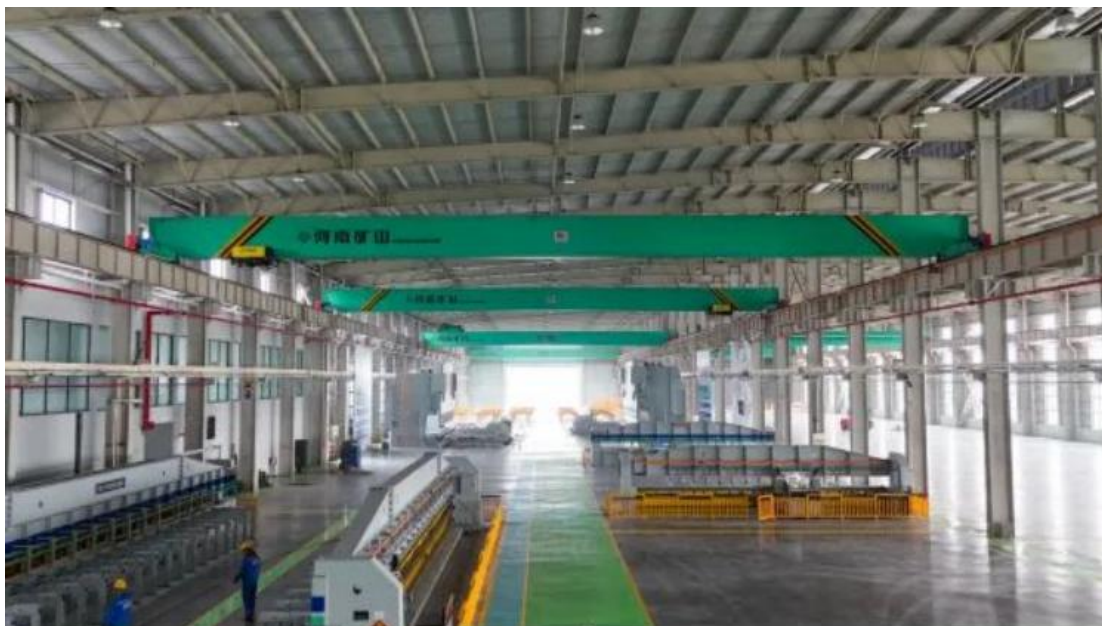
图 3.1.1-1 现有项目现场照片
