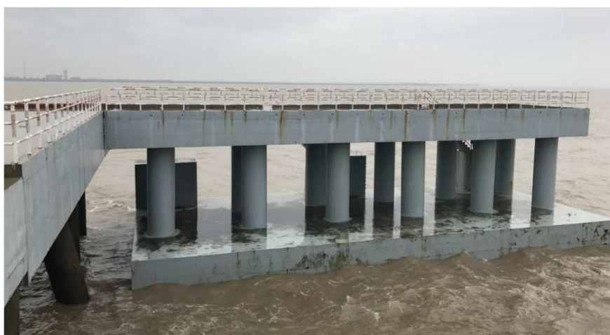
图3.1-9 南侧泊位靠船墩及上部平台
