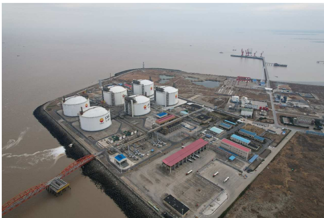
照片 6 本项目东侧中石油接收站现状
