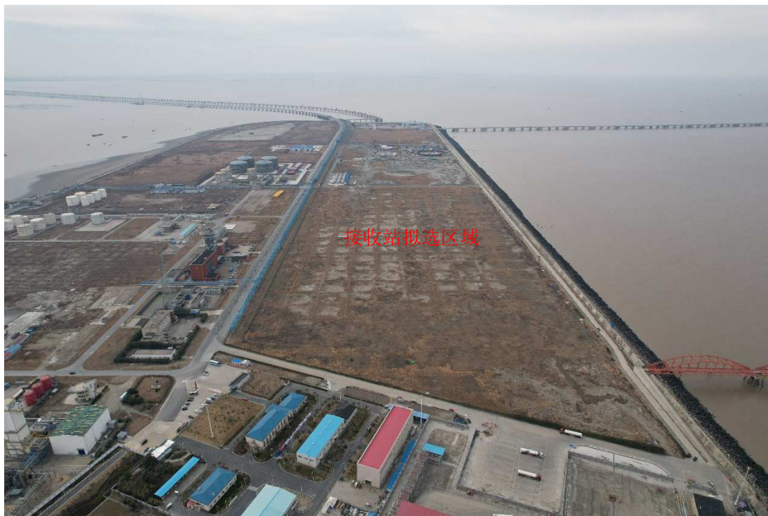
照片 3 接收站拟建区域现状（航拍图）
