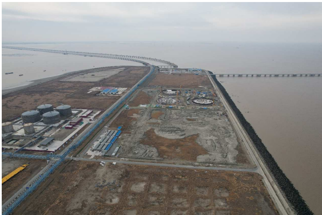
照片 5 本项目西侧国信接收站建设现状
