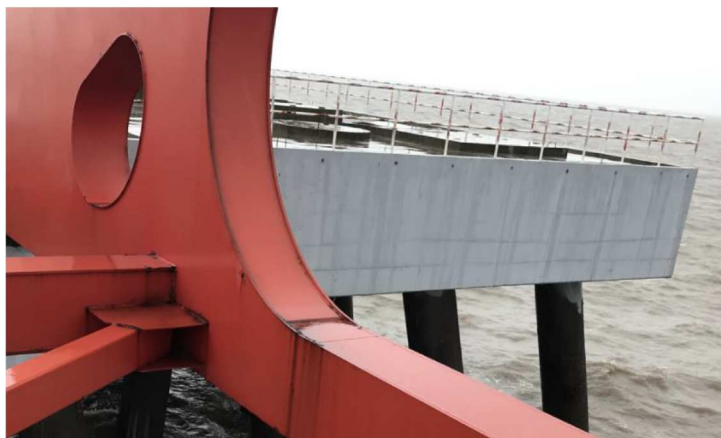
图 3.1-14 海水泵房平台
