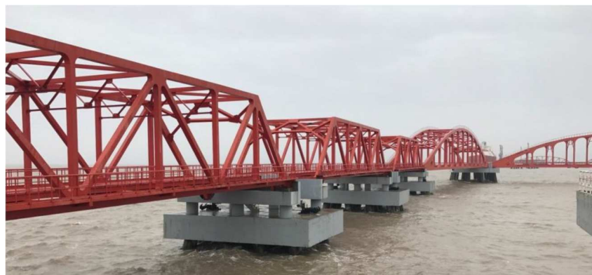
图 3.1-12 4#~6#系缆墩及联系桥
