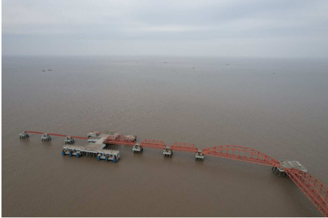
照片 8 10 万吨级石化码头
