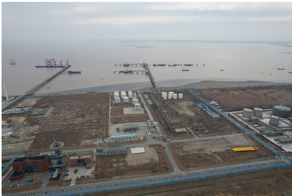
照片 10 阳光岛南侧码头
