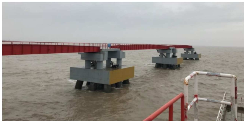
图 3.1-11 1#~3#系缆墩及联系桥
