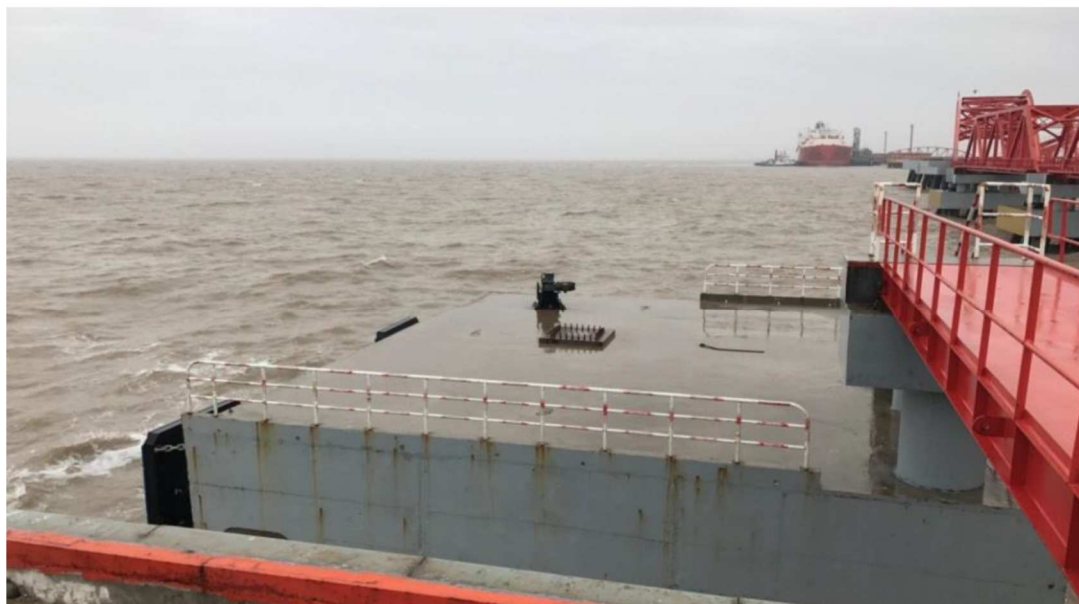
图3.1-6 北侧泊位靠船墩
